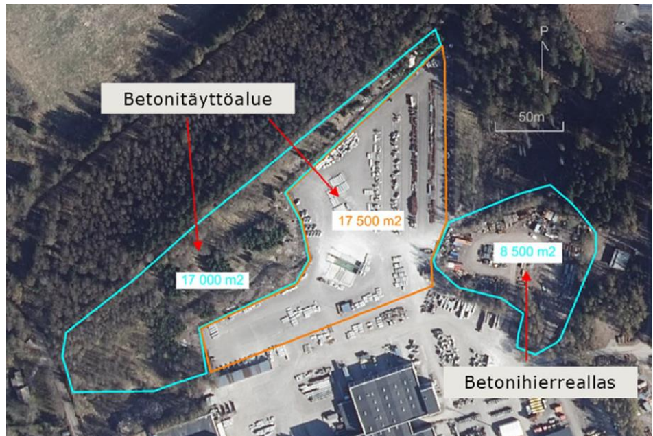
Kuva 11. Betonitäyttöalue ja betonihierrealas (© AFRY 2024).
